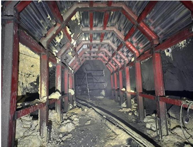
*Figura 3: Rehabilitación de la galería tras el relleno con resina expansiva*
