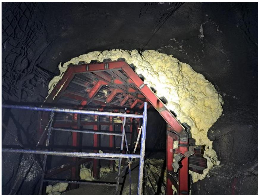
*Figura 1: Relleno de cavidad con resina expansiva*
