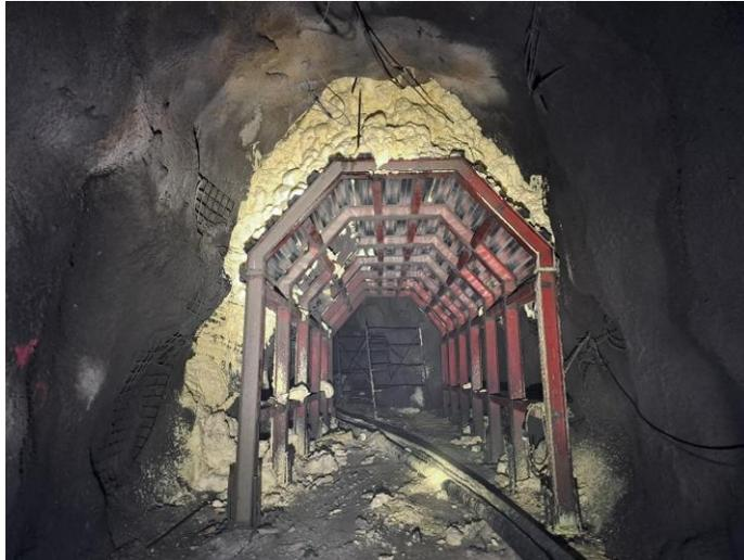
*Figura 2: Cavity asegurada con resina expansiva*
