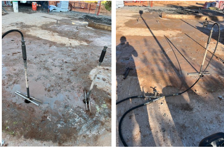
Figura 5. Inicio de inyección de resina.
